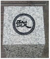
写真. 既設の石柱。幅 18cm×奥行 15cm×高さ手前 108cm・奥 117cm (白御影石本磨き仕上げ)
