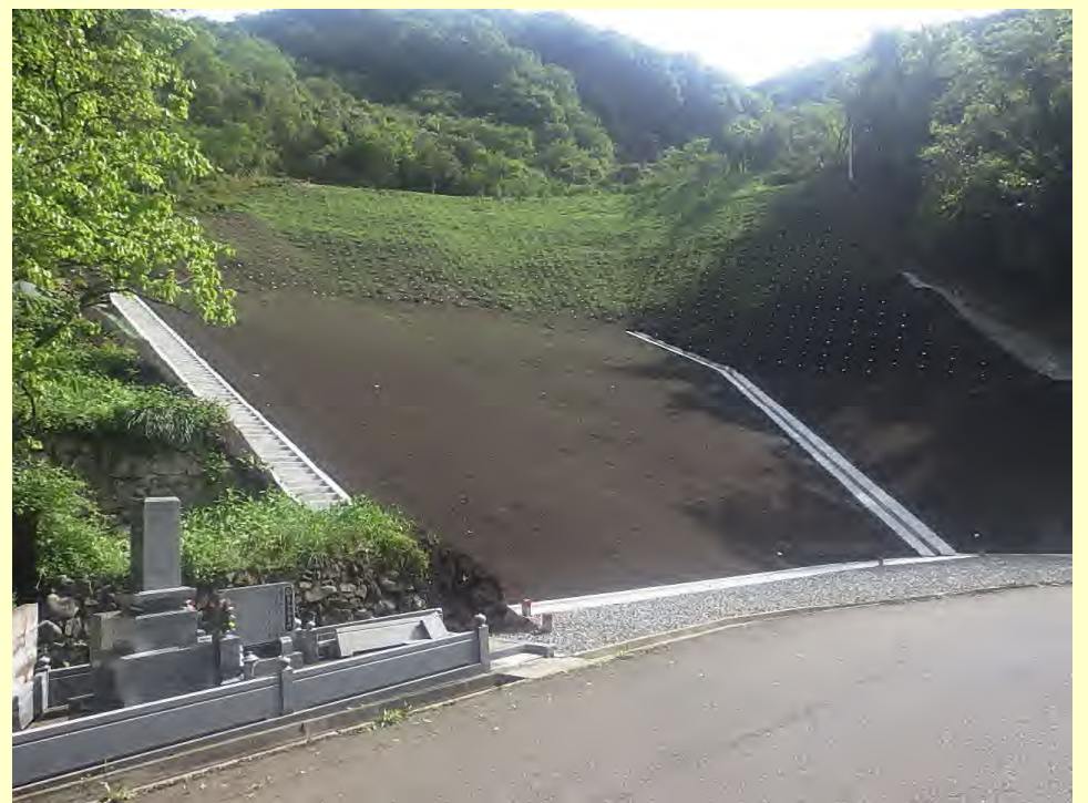
【附属物設置工】
