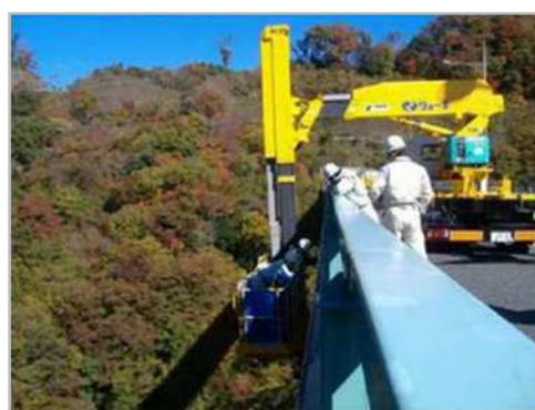
写真 1. 2 橋梁点検車による施設点検の実施状況
