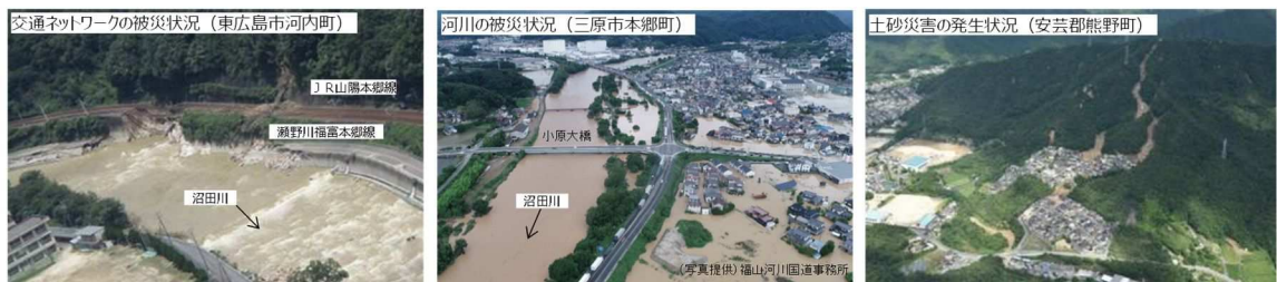
写真1.1 平成30年7月豪雨における災害発生状況
