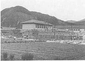
建設中の温室(可部園芸支場)
