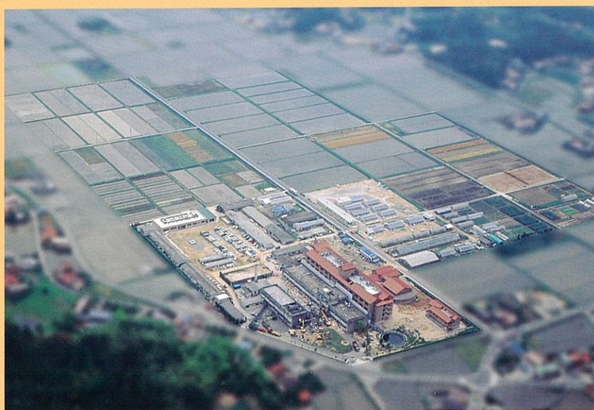
センター敷地(旧館取り壊し中)
