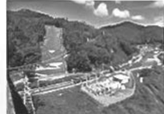
山腹工(東広島市)
