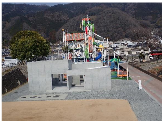
府中市こどもの国公園 こどもの広場トイレ 完成写真
