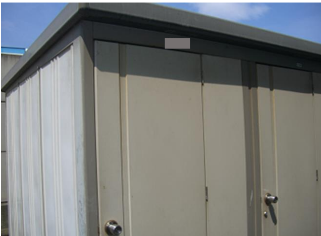
外部倉庫（外観）
