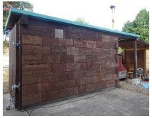
温度範囲 外気温+約20~30℃ 用途 CLTブロック外壁と温水加温で天然 乾燥に近い緩やかな乾燥を行います。 2021ウッドデザイン賞を受賞。
