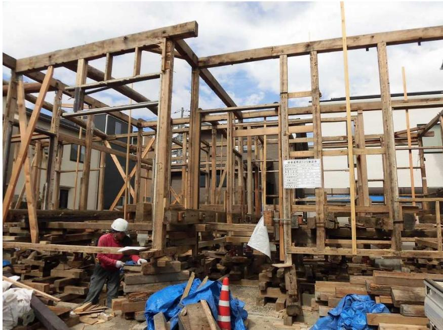
揚家の様子。築約 70 年の住宅で、無筋の基礎で劣化も激しかったため打ち換えることとした。建物全体をジャッキで少しづつ持ち上げている。
