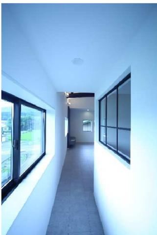
←廊下の窓からの採光を、外壁に面していない寝室へ間接的に取込むため室内窓を設置した。
