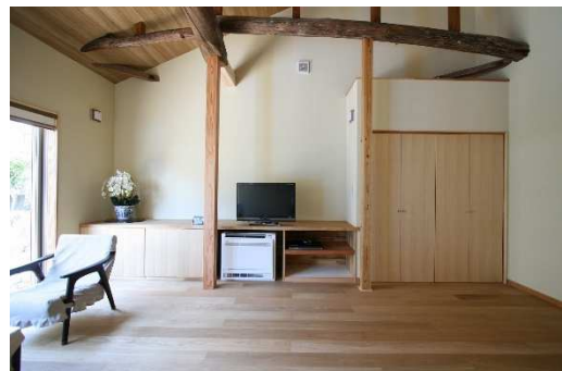
←リビングは、傾斜天井で伸びやかな空間になっている。古材の柱や梁もいい味を出している。造作のテレビ台は既存柱の間隔に合わせた。設計時に心配されていたが、違和感なく仕上がっている。↓
