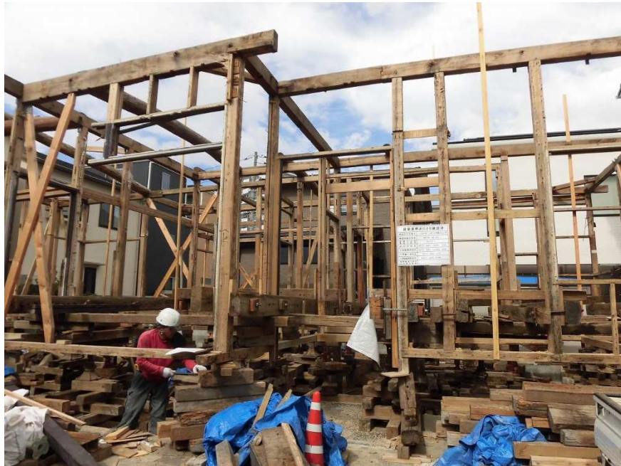
揚家の様子。築約 70 年の住宅で、無筋の基礎で劣化も激しかったため打ち換えることとした。建物全体をジャッキで少しずつ持ち上げている。
