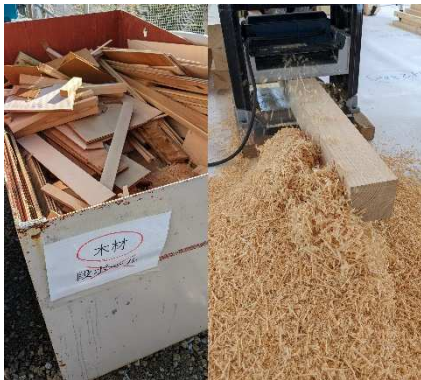
←建築時に出た木の端材を木屑にし土壌改良材として再利用することで廃棄物による環境負荷の軽減を図った。
