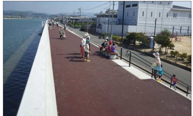
尾道糸崎港海岸堤防
