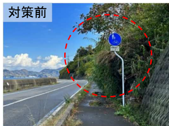
【道路法面の伐木】
