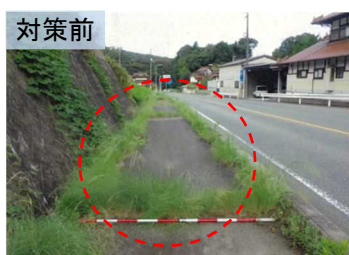
【歩道の防草対策(舗装修繕)】
