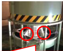
劣化予測システムおよび状態監視の精度向上を目的とした排水ポンプ分解整備前の振動データのさらなる蓄積。（R5.7）
