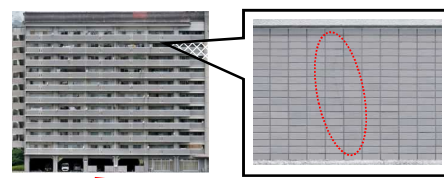
ドローン等調査（オルソ画像の活用）による点検仕様を改訂
