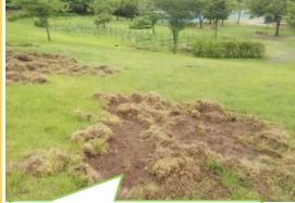
対策実施前の被害状況(R4.7)
