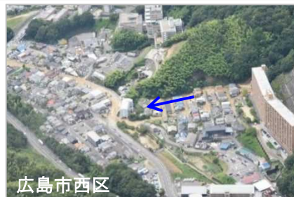
令和3年8月豪雨災害の被災状況
