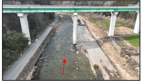
堆積土除去後
