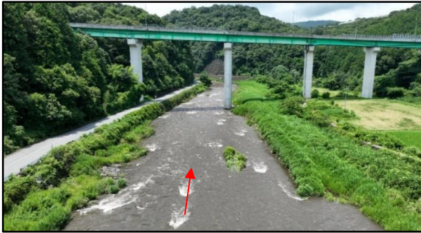
堆積土除去前
