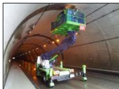
トンネル点検
