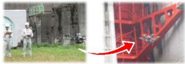
ドローンを活用した施設点検
