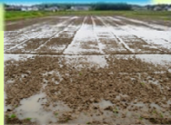
地面の凹凸で水たまりが発生
