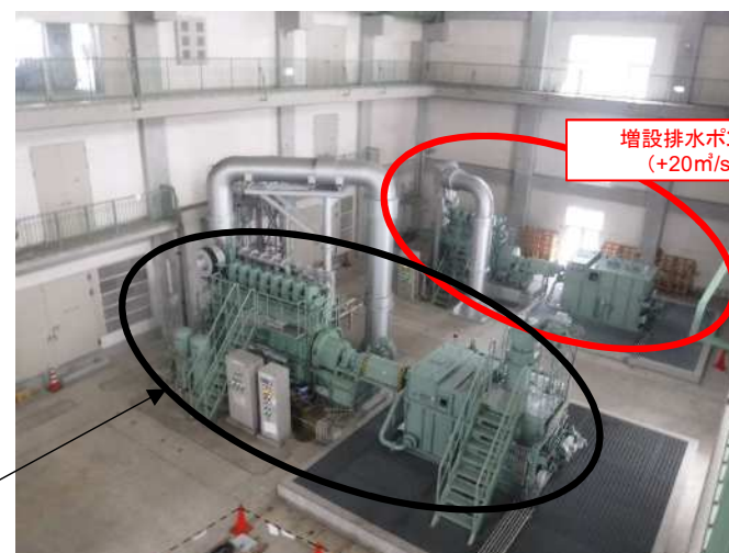
整備後(令和5年3月)
