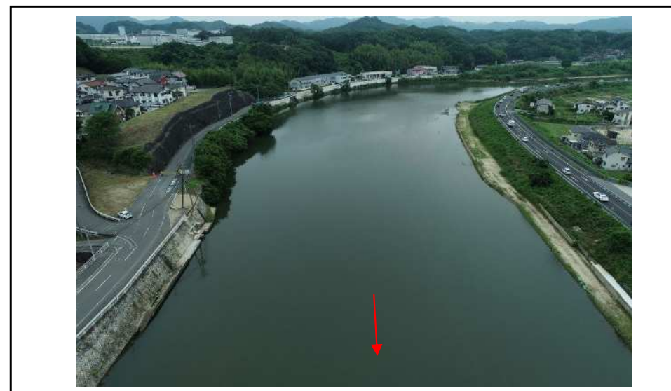
整備後(令和5年6月)
