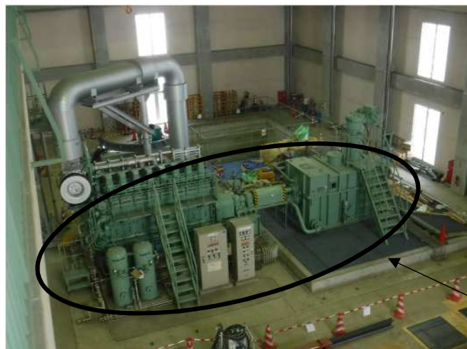
整備前(令和3年9月)
