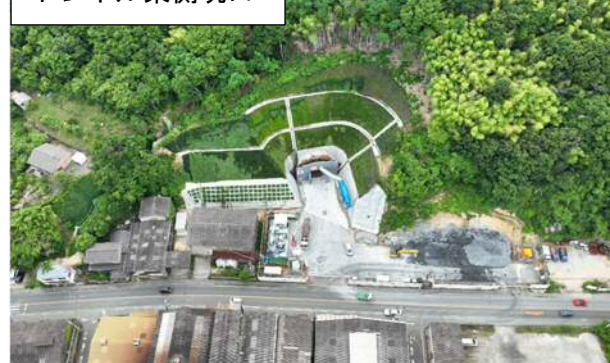
トンネル東側坑口
