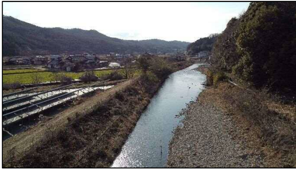
堆積土除去前
