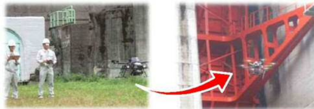
ドローンを活用した施設点検
