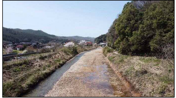
堆積土除去後
