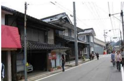
街道東城路周辺地区のまちなみ
