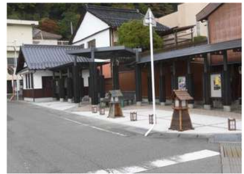
ポケットパーク・トイレ整備
