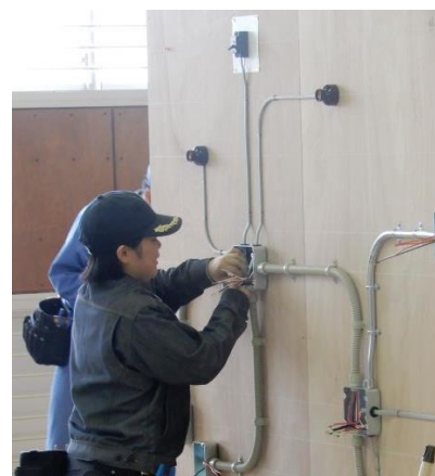
広島県大会の様子（電気工事）
