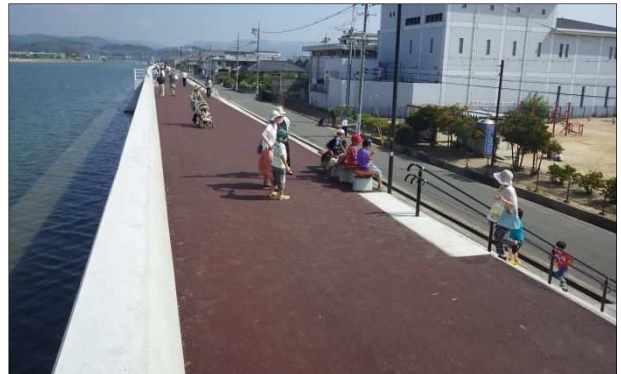
尾道糸崎港海岸堤防
