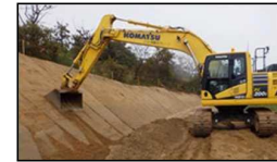
ICT建設機械による施工
