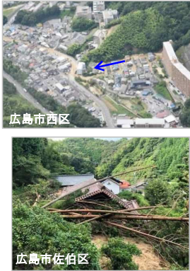
令和3年8月豪雨災害の被災状況
