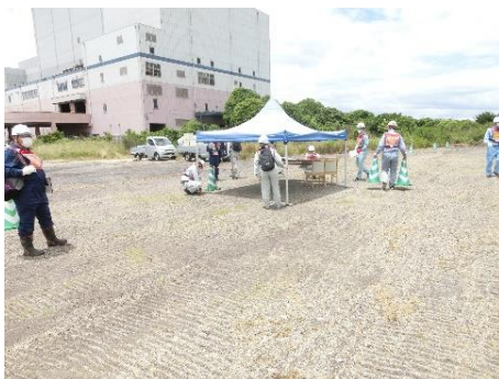
仮置場の設置
