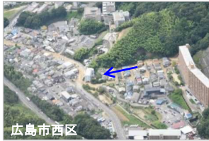
令和3年8月豪雨災害の被災状況
