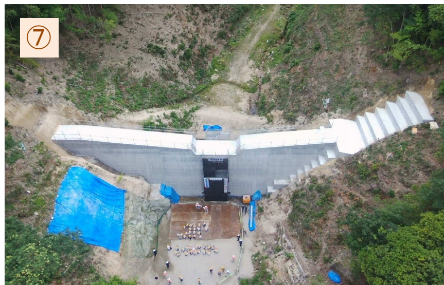
天地川支川8 砂防堰堤（本体工）令和3年4月30日完成
