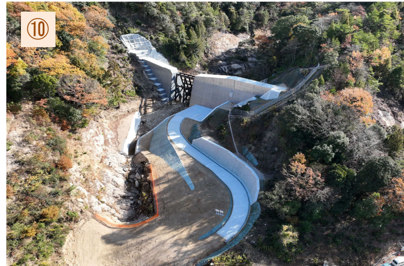
天地川 I -1 令和4年12月12日完成
