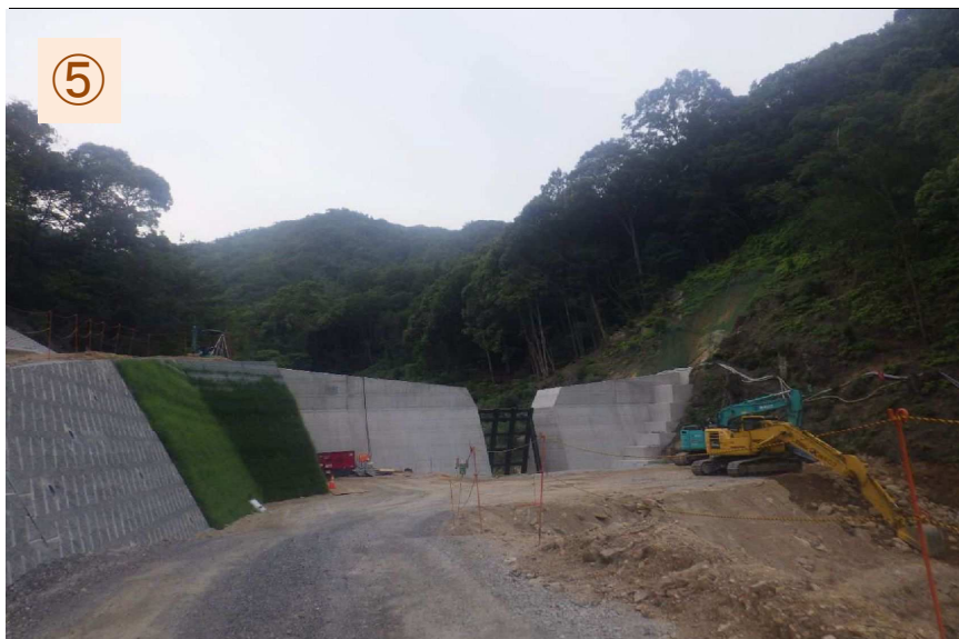
天地川支川2 砂防堰堤（本体工）令和3年3月29日完成
