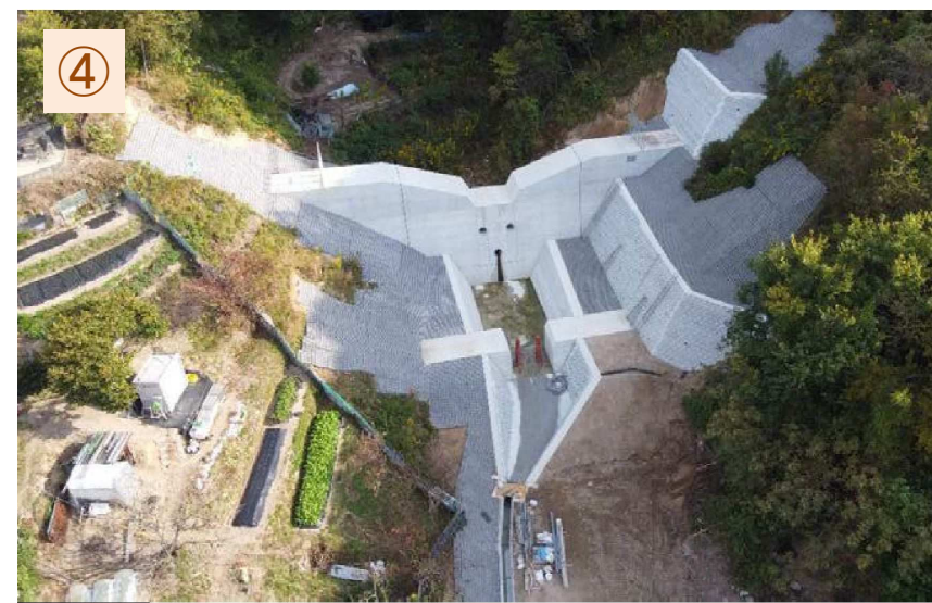
④ 天地川支川5 砂防堰堤（本体工）令和2年2月12日完成
