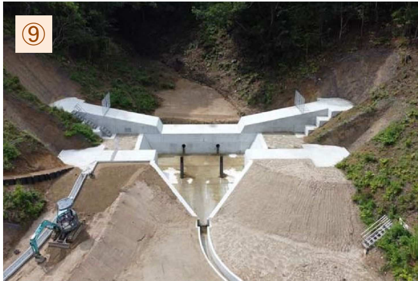
天地川支川9 砂防堰堤（本体工）令和3年1月15日完成
