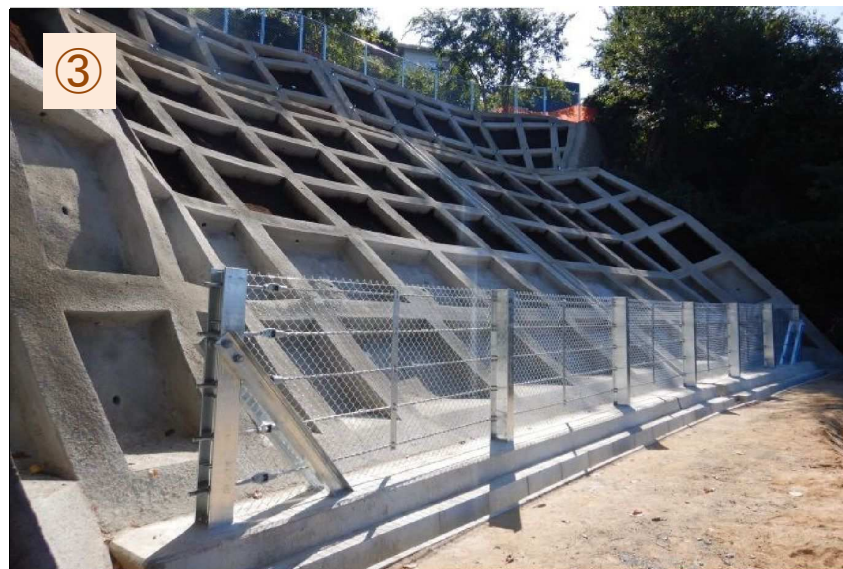
法大神地区急傾斜対策（法砕工）令和元年10月11日完成
