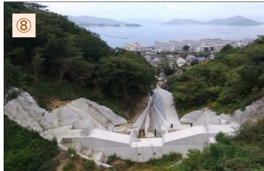
天地川支川10 砂防堰堤（本体工）令和2年12月18日完成
