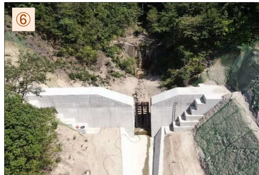
天地川支川6 砂防堰堤 令和3年7月30日完成
