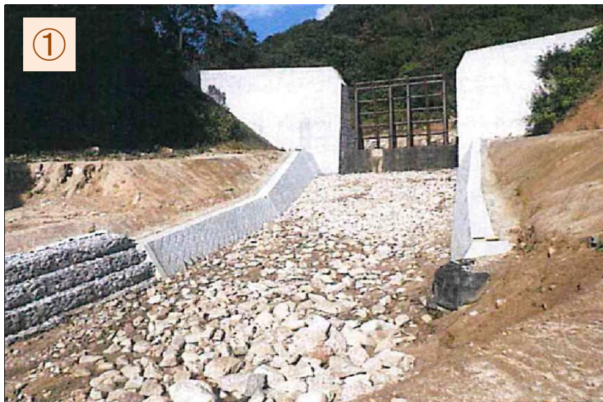
① 天地川（上流）砂防堰堤（本体工）令和元年12月12日完成
