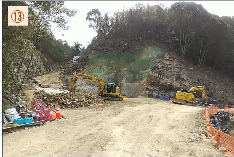
天地川Ⅲ-1 掘削工状況
