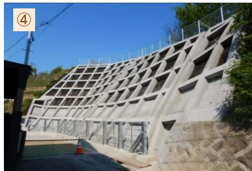
釜ヶ谷地区急傾斜対策（法砕工）令和2年5月8日完成
