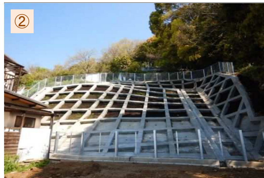
西6441地区急傾斜対策（法砕工）令和2年4月24日完成
