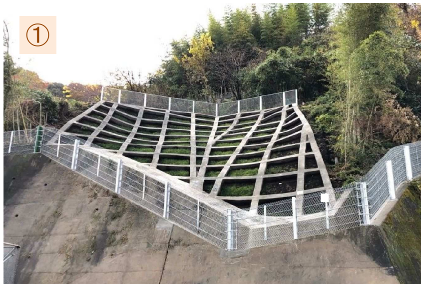
西側地区急傾斜対策（法砕工）令和元年12月25日完成
