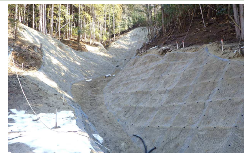
3 施工状況（改良土吹付、ラス張り完了）
