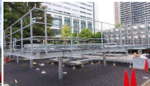
嵩上げ架台（洪水・汚染土対策）
