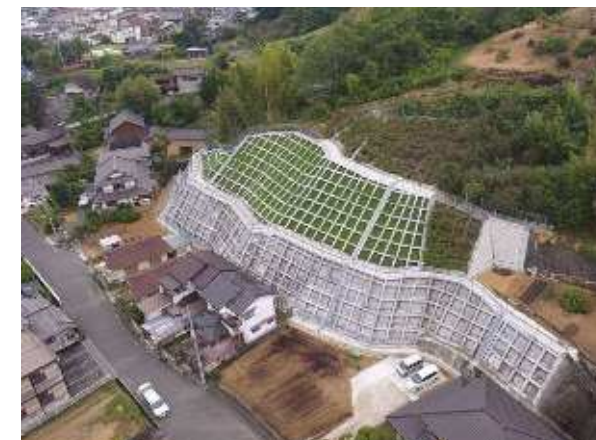
急傾斜地崩壊防止施設の整備
