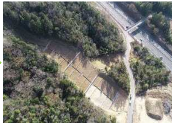
施工後の状況(令和3年2月完成)
