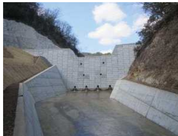
砂防堰堤の整備
