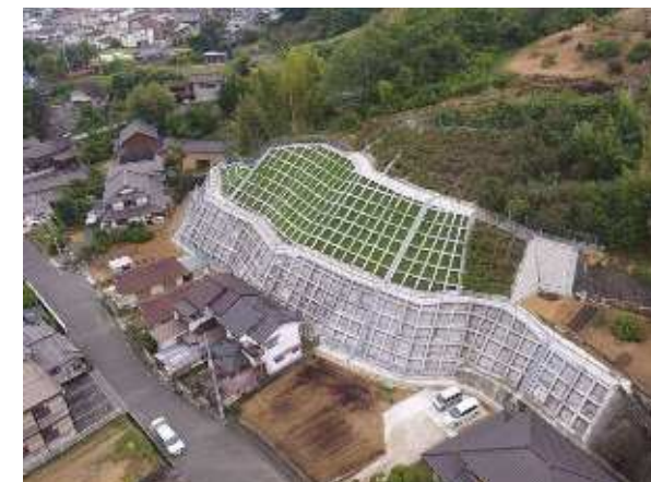
急傾斜地崩壊防止施設の整備
