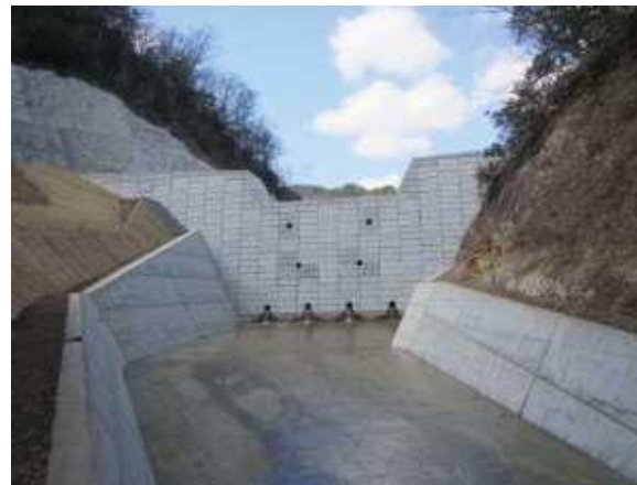
砂防堰堤の整備
