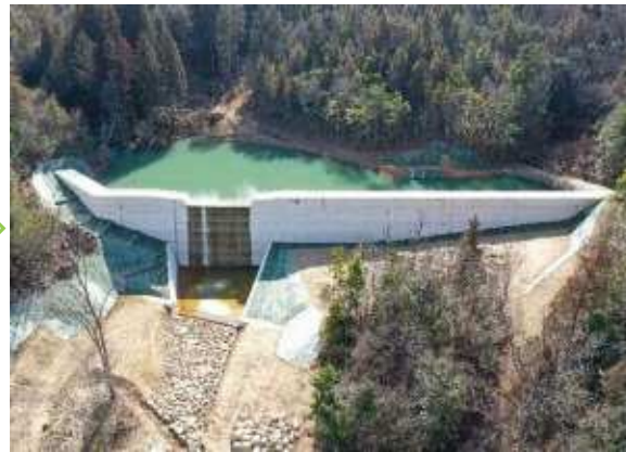
施工後の状況(令和3年4月完成)
