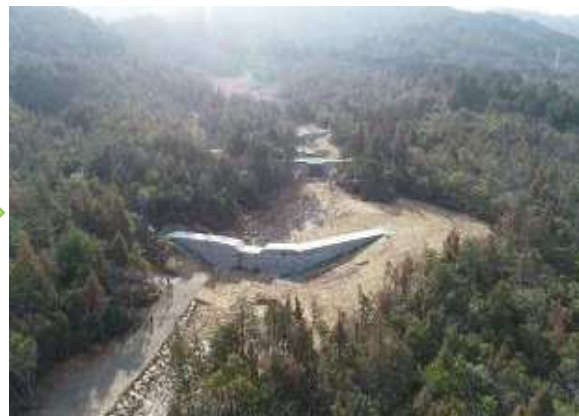
治山ダム3基設置(令和3年4月完成)
