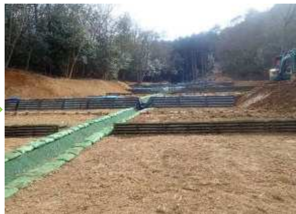
施工中の状況
