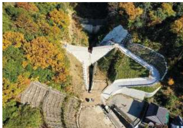
神長川2-23-13溪流砂防堰堤 (広島市安芸区矢野東地区)
