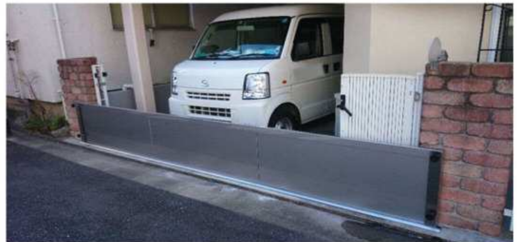
【止水板の設置例】
