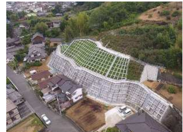
急傾斜地崩壊防止施設の整備
