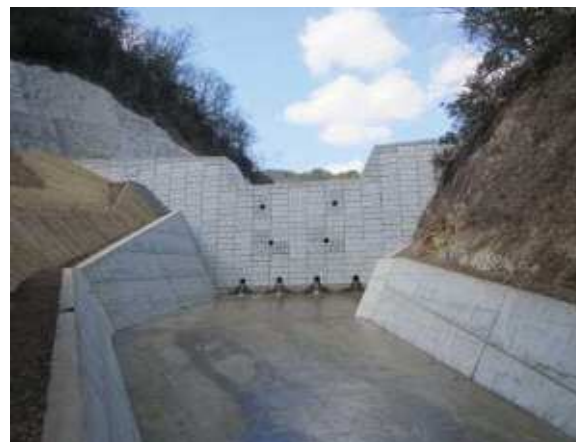
砂防堰堤の整備
