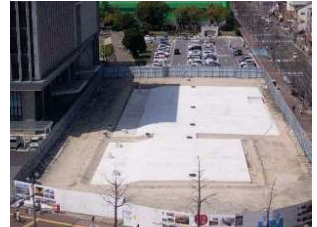
施設全景(工事中)
