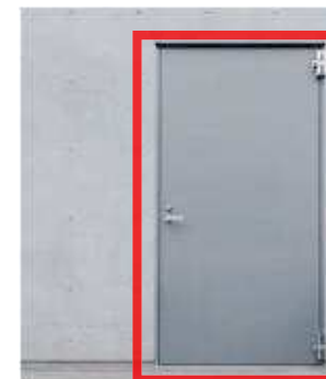
防水扉の設置
