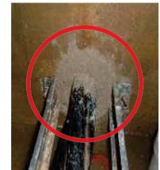
ケーブル貫通部の閉塞
