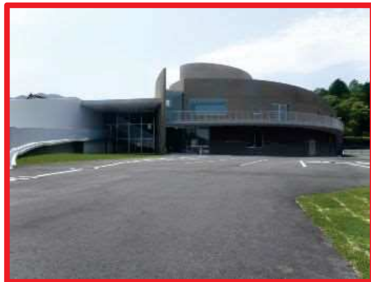
熊野東防災交流センター
