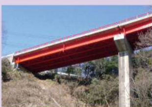
【橋梁補修】 国道 182 号 三曲橋 (福山市加茂町) 【H29 完了】
