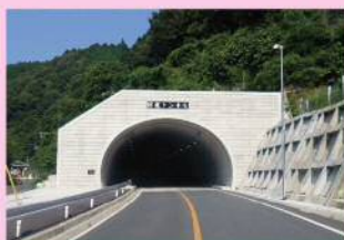
【バイパス整備】 国道186号 御園バイパス (大竹市防鹿) 【H29 部分完成】
