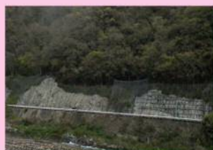
【法面对策】 国道191号 坪野工区 (山県郡安芸太田町) 【R2 完成】
