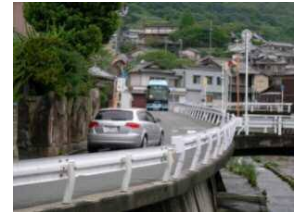
町道での離合状況
