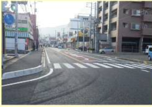
国道 2 号 西御所～新浜工区 (尾道市西御所町) 【R2 完成】
