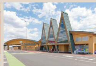
道の駅「三矢の里あきたかた」 (安芸高田市吉田町) 【R2 完成】
