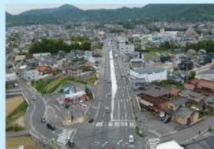
(主) 矢野安浦線 川角工区 (安芸郡熊野町) 【R2 完成】
