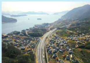
国道2号 木原道路 (尾道市福地町～三原市糸崎) 【R2 完成】
