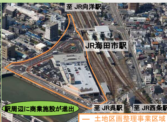
駅前広場等の整備が概成した海田市駅南側
