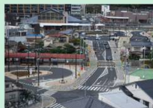
(都) 廿日市駅通線 (廿日市市駅前) 【H30 完成】
