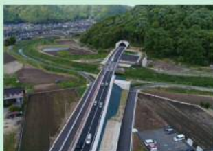
国道 313 号 神辺バイパス (福山市神辺町) 【H29 完成】
