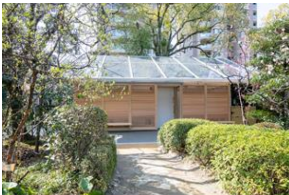
縮景園内事務棟東トイレ 完成写真
