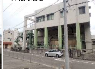
本川排水機場
