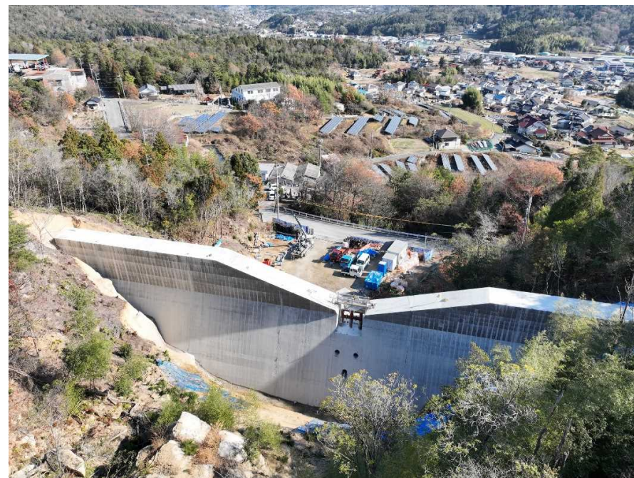
熊野川支川2 安芸郡熊野町 砂防事業
