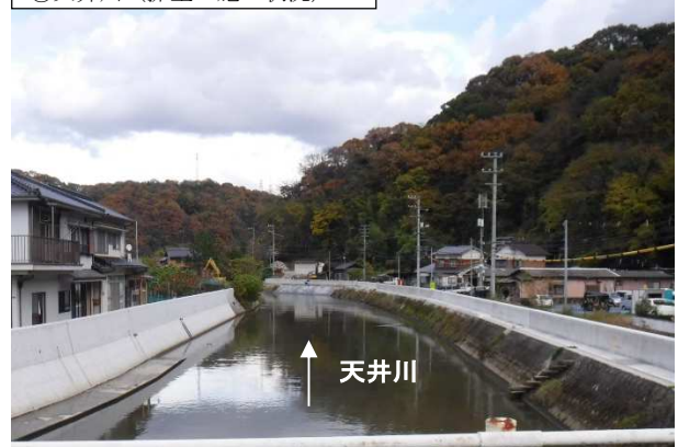
②天井川（擁壁工施工状況）
