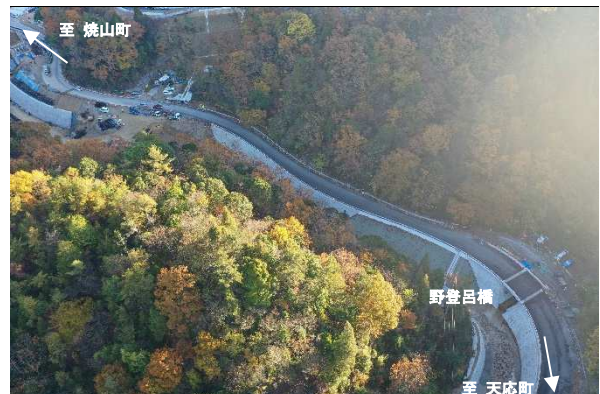
写真②舗装工施工状況
