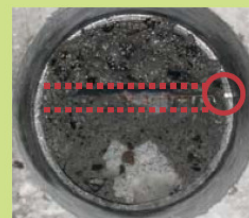
今回開発した鉄筋感知装置を使った場合。鉄筋の損傷を大幅に低減
