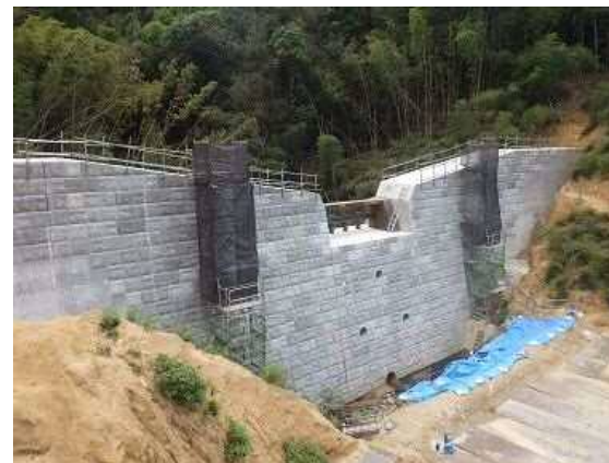
工事完了（令和3年10月21日）
