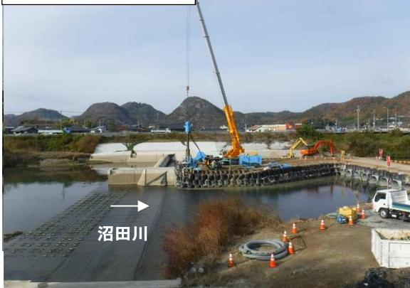
②天井川（擁壁工施工状況）
