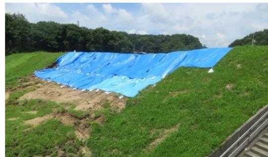
写真2 ため池の緊急点検及び応急措置の状況
