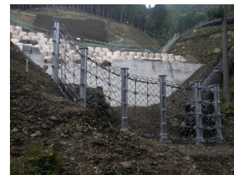
<本堤の仮設として>
