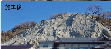
施工事例（広島県呉市）
