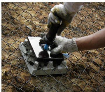
頭部施工中写真
