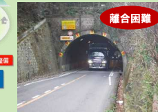
国道487号(江田島市)
