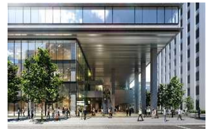
高層棟低層部
