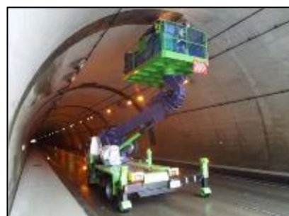
トンネル点検
