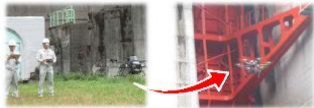
ドローンを活用した施設点検
